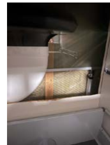
Vegg under vindu er ikke kledd på grunn av plass for sprutplate.
