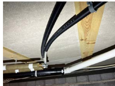
Uisolert vannledning
