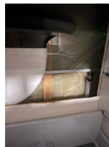
Vegg under vindu er ikke kledd på grunn av plass for sprutplate.
