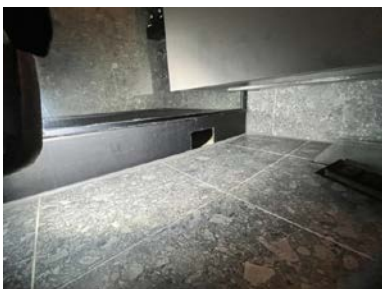
Åpning på side av dusjgulv for adkomst til sluk.
