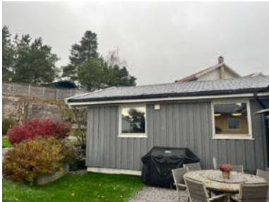
Synlig fuktsikring på utside av grunnmur
