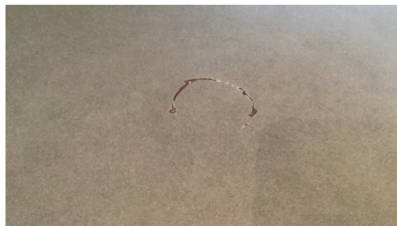
Skade på benkeplate.
