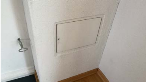
Sotluke i stue.
