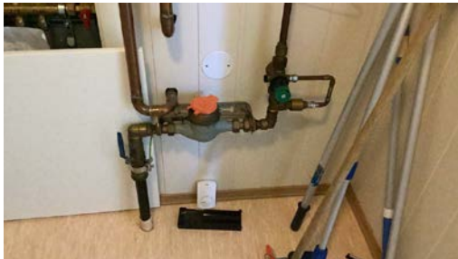
Vanninntak med måler og stoppekran
