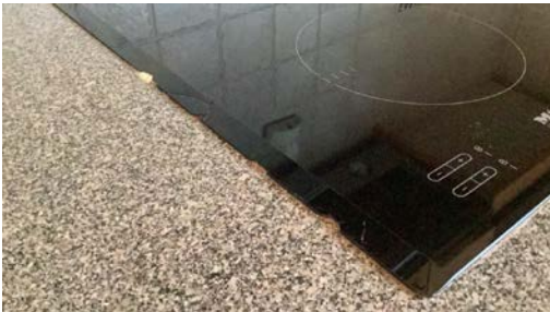
Skader i kanter på platetopp.
