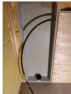
Vannrett kasse i vegg for vannsisterne toalett
