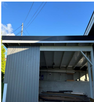
Beslag på kant av tak på carport montert etter befaring
