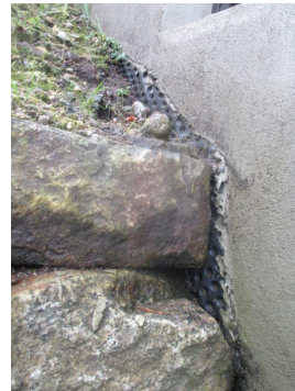
Synlig fuktsikring inntil grunnmur.
