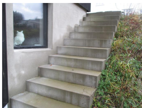
Støpt utvendig trapp.
