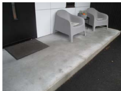
Støpt overbygget plattning.
