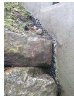
Synlig fuksikring inntil grunnmur.
