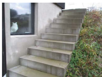
Støpt utvendig trapp.
