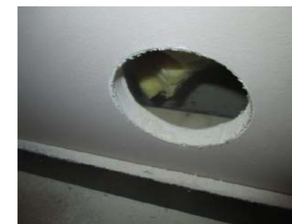
Hulltaking i utfored vegg på ene soverommet.
