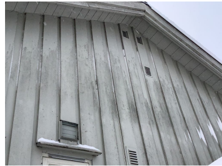
Værslitt bordkledning.
