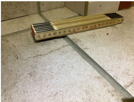
Sprang mellom gulvfliser.
