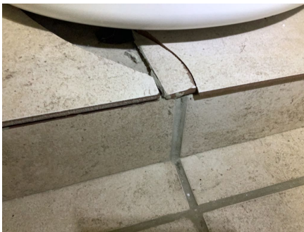
Sprang mellom gulvfliser.
