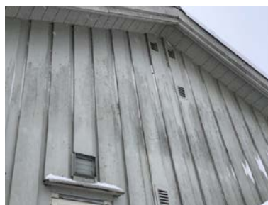
Værslitt bordkledning.
