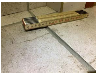
Sprang mellom gulvfliser.
