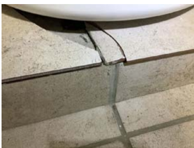
Sprang mellom gulvfliser.
