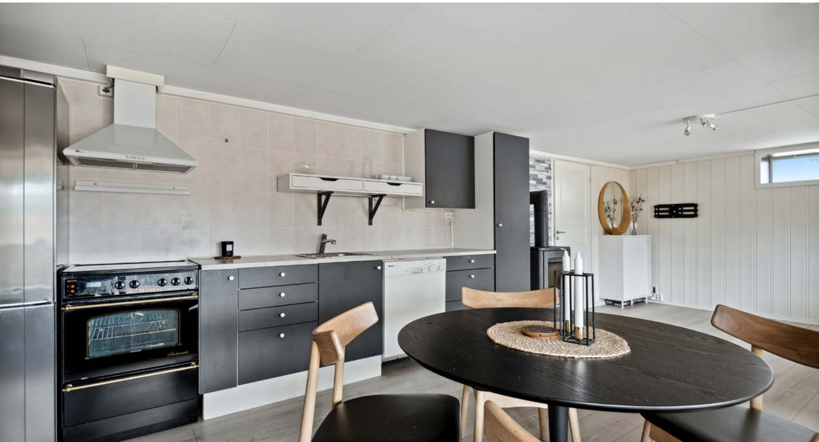
Kjøkkeninnredning i åpen løsning med stuen med varierende alder og bruksslitasje. Innredningen har glatte fronter, laminert benkeplate med nedfelt oppvaskkum og kitchenboard i benkeryggen.
