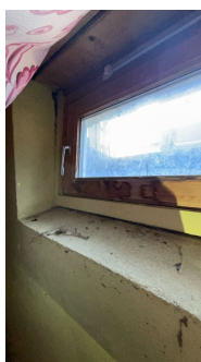
Vinduer i kjeller har sklid i ut, må ses i sammenheng med grunnmur.
