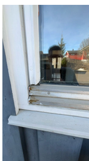
Vinduer i kjeller har sklid i ut, må ses i sammenheng med grunnmur.
