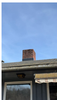
Pipe anbefales helbeslått over tak.
