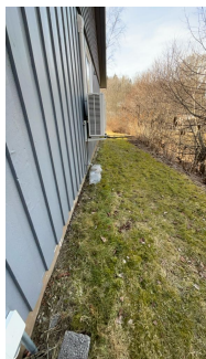
Det er påvist dårlig fall eller flatt terreng inn mot grunnmur og dermed muligheter for større vannansamlinger.
