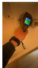
Ved bruk av fuktindikator på utsatte steder registrerte jeg ingen unormale verdier.
