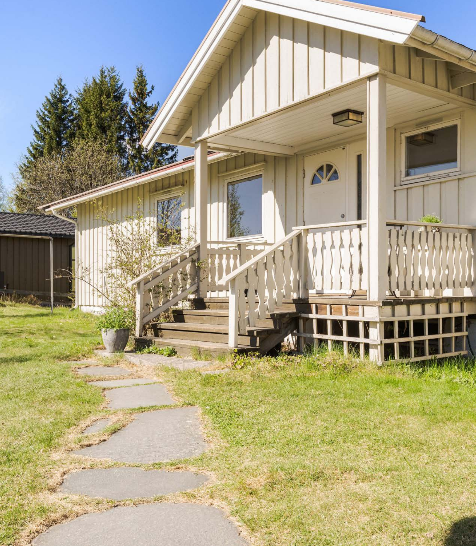
Fra garasjen er det en koselig gangsti med steiner til inngangspartiet.
