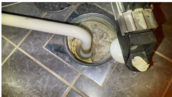
Sluk med smøremembran.
