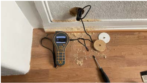
Fuktmåling i vegg mot bad.
