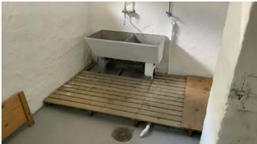
Enkelt vaskerom i kjelleren
