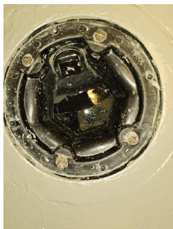
Tettesjiktets tilslutning til sluk - Sluk vaskerom
