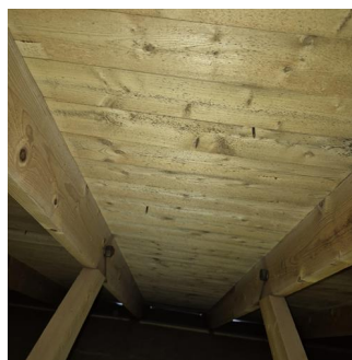
Synlige overflater (taktro, vegger, gulv, o.l) - Svertesopp undertak loft
