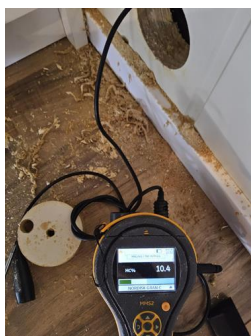
Kontroll i lukkede konstruksjoner - Fuktmåling utlektet kjellevegg
