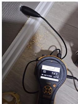
Utført kontroll i tilliggende konstruksjon - Fuktmåling bad
