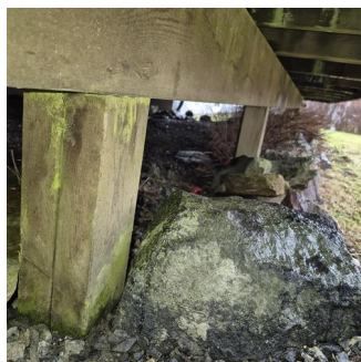
Konstruksjon og fundamenter - Fundament terrasse
