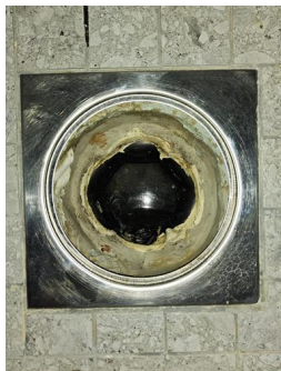
Tettesjiktets tilslutning til sluk - Sluk bad
