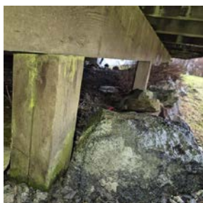
Konstruksjon og fundamenter - Fundament terrasse
