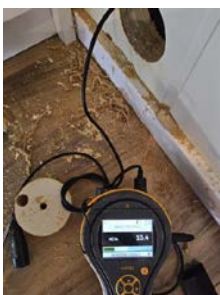
Kontroll i lukkede konstruksjoner - Fuktmåling utlektet kjellevegg
