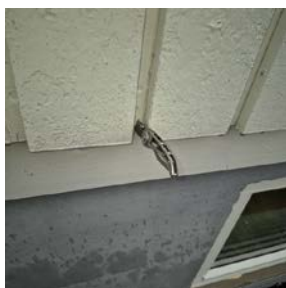
Ytterkledning (fasademateriale, vannbord, utvendig listverk, o.l.) - Råteskade panel mot øst
