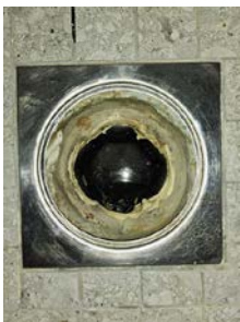
Tettesjiktets tilslutning til sluk - Sluk bad
