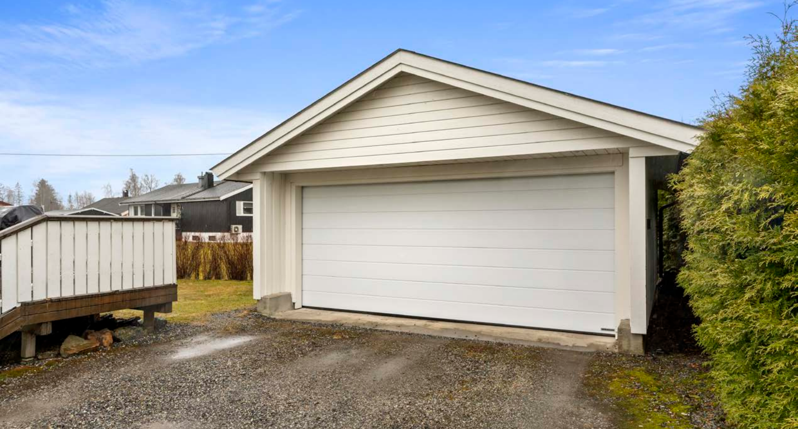
Dobbel garasje - med elektrisk garasjeport fra 2024.
