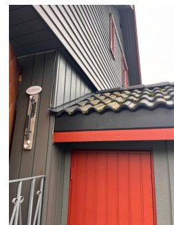
Kort avstand fra kledning til taktekking.
