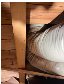
Ingen tegn til skader i takgjennomføring
