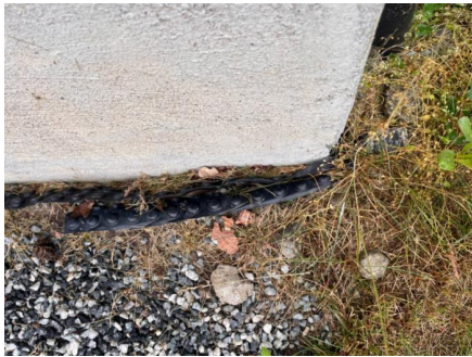
Synlig vorteplast over terreng, ikke avsluttet med toppliste
