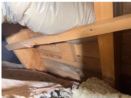
Ingen tegn til skader i takgjennomføring
