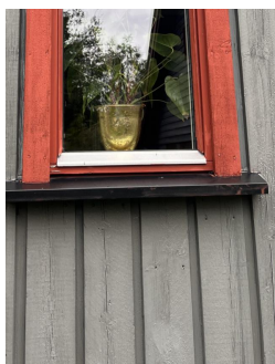
Omramming uten luftespalte mot vannbrett
