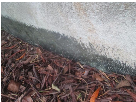
Deler av fuktsikringen.
