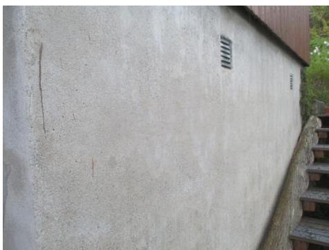
Deler av grunnmur.
