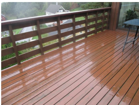
Deler av terrasse ut i fra stue.
