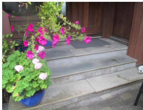
Støpt trapp med repos ved inngangsparti.
