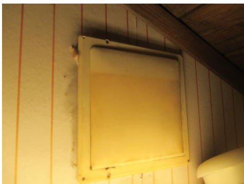
Ventil i ytterveggen.
