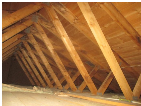
Deler av takkonstruksjonen.
