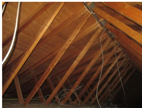
Takstoler og rupanel som undertak.
