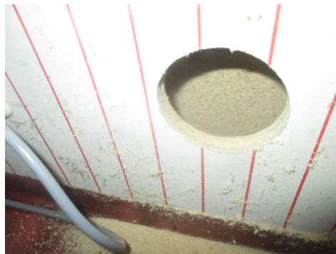
Hulltaking i vegg mot stue.
