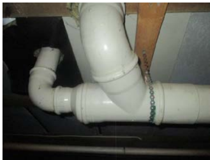
Avløpsrør i grovkjeller.
