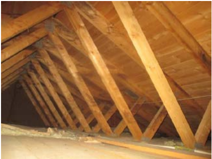
Deler av takkonstruksjonen.
