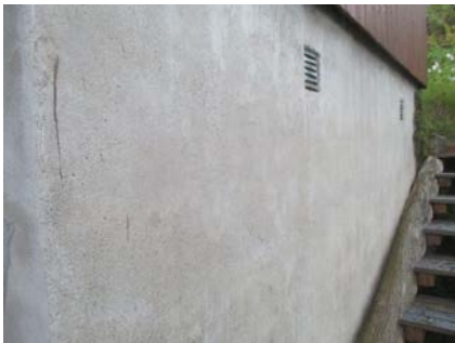
Deler av grunnmur.
