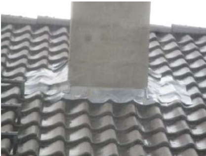
Bunnbeslag på pipe over tak.
