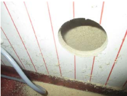
Hulltaking i vegg mot stue.
