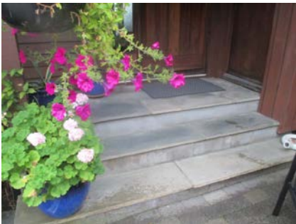
Støpt trapp med repos ved inngangsparti.
