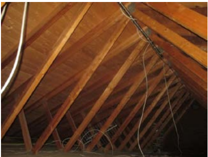
Takstoler og rupanel som undertak.
