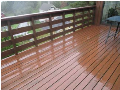
Deler av terrasse ut i fra stue.
