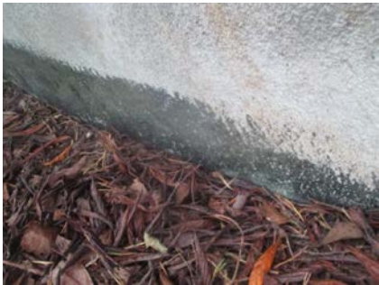
Deler av fuktsikringen.
