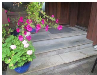
Støpt trapp med repos ved inngangsparti.
