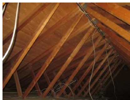
Takstoler og rupanel som undertak.
