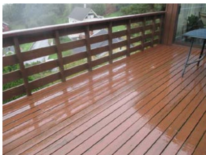
Deler av terrasse ut i fra stue.
