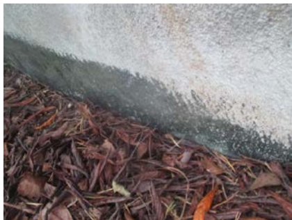
Deler av fuktsikringen.
