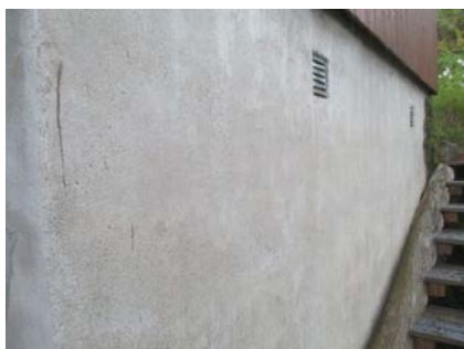
Deler av grunnmur.
