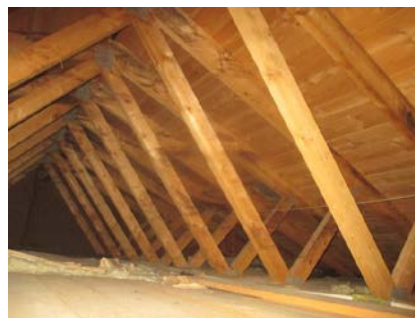
Deler av takkonstruksjonen.
