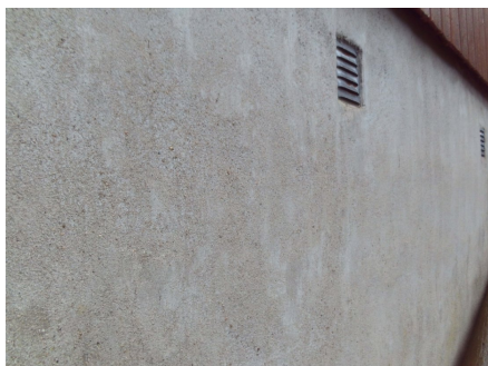
Deler av grunnmuren.
