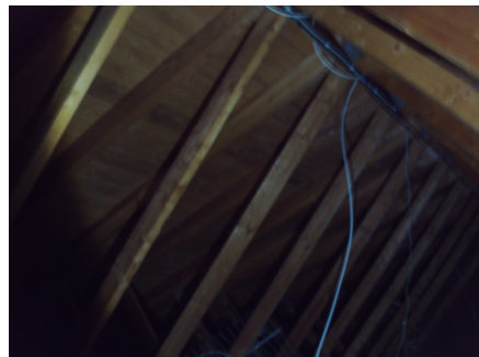
Deler av takkonstruksjonen
