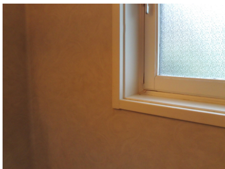
Vindu i våtsone ved dusj.
