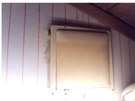
Ventil i ytterveggen.
