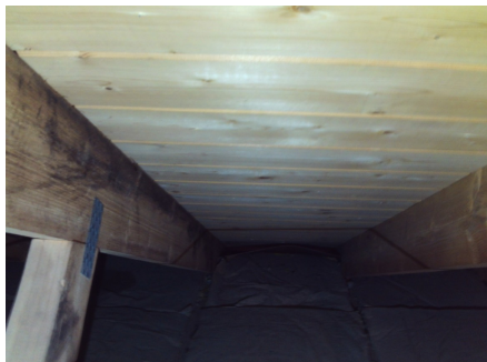
Takstoler med rupanel som undertak.
