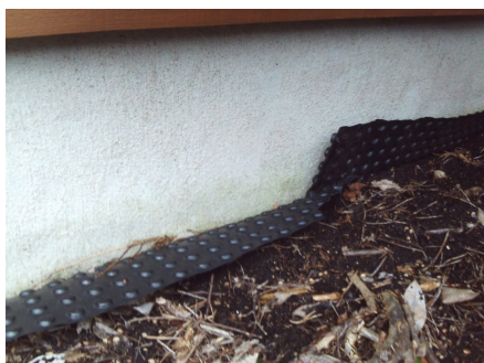
Noe synlig fuktsikring av type platon.
