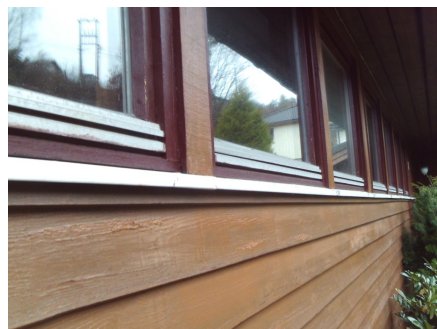
Deler av kledningen med tilhørende belistninger
