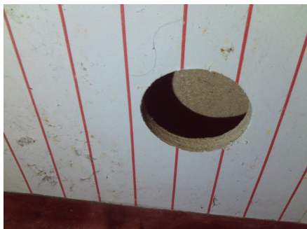
Hulltaking i vegg mot stue.
