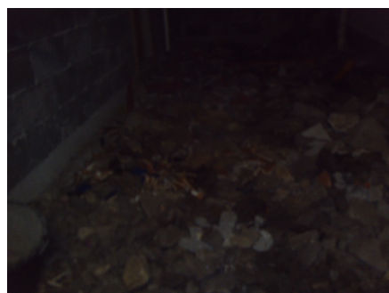
Ikke støpt gulv i grovkjeller.
