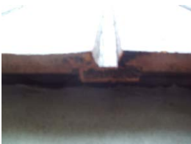
Bunn av kledning mot grunnmur.
