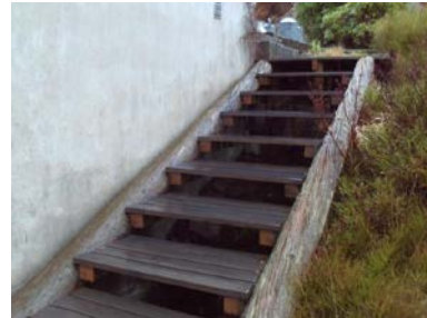
Trapp langs ene endeveggen.
