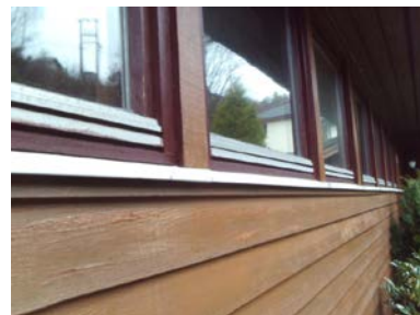
Deler av kledningen med tilhørende belistninger
