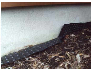
Noe synlig fuktsikring av type platon.
