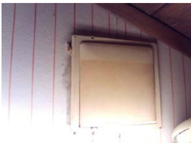
Ventil i ytterveggen.
