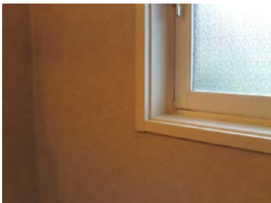
Vindu i våtsone ved dusj.
