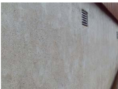
Deler av grunnmuren.
