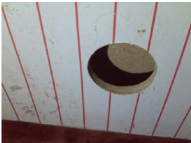
Hulltaking i vegg mot stue.
