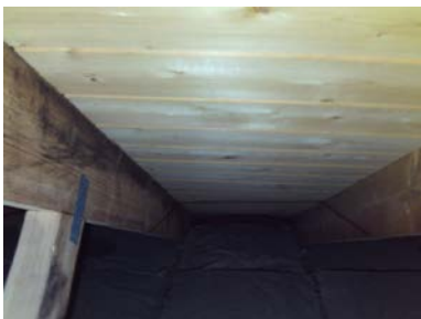
Takstoler med rupanel som undertak.
