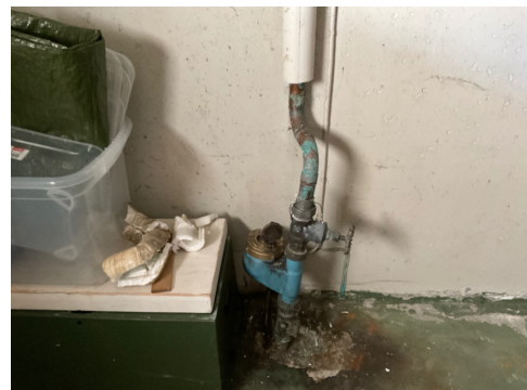
Hovedstoppekran for bygningen
