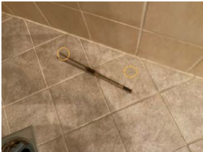
Bom under flis i dusjnische
