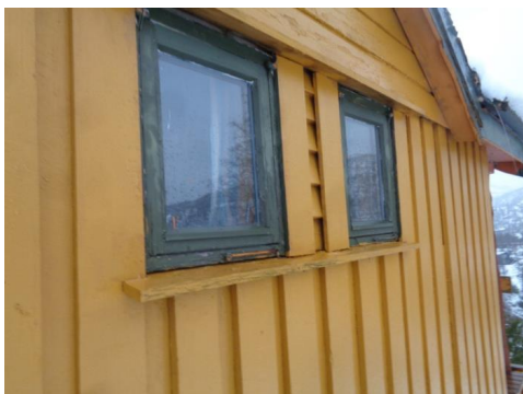
Eldre vinduer i boligen.
