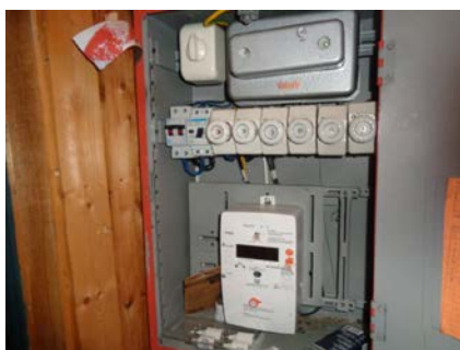
Sikringskap i gang.
