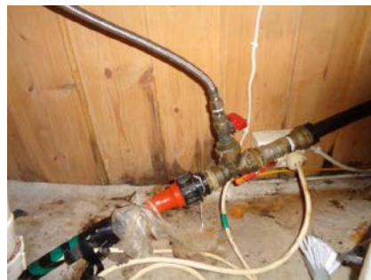
Vann tilkoblet med hageslange.
