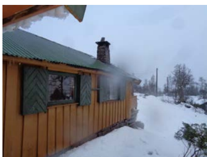
Det er ikke montert takrenner eller nedløp på boligen.
