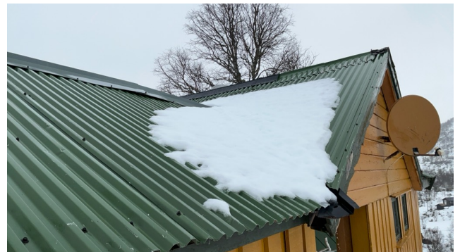
Delvis snødekket yttertak.
