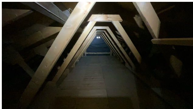
Adkomst til kaldtloft via luke med stige.
