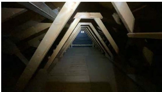
Adkomst til kaldtloft via luke med stige.
