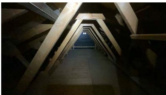
Adkomst til kaldtloft via luke med stige.
