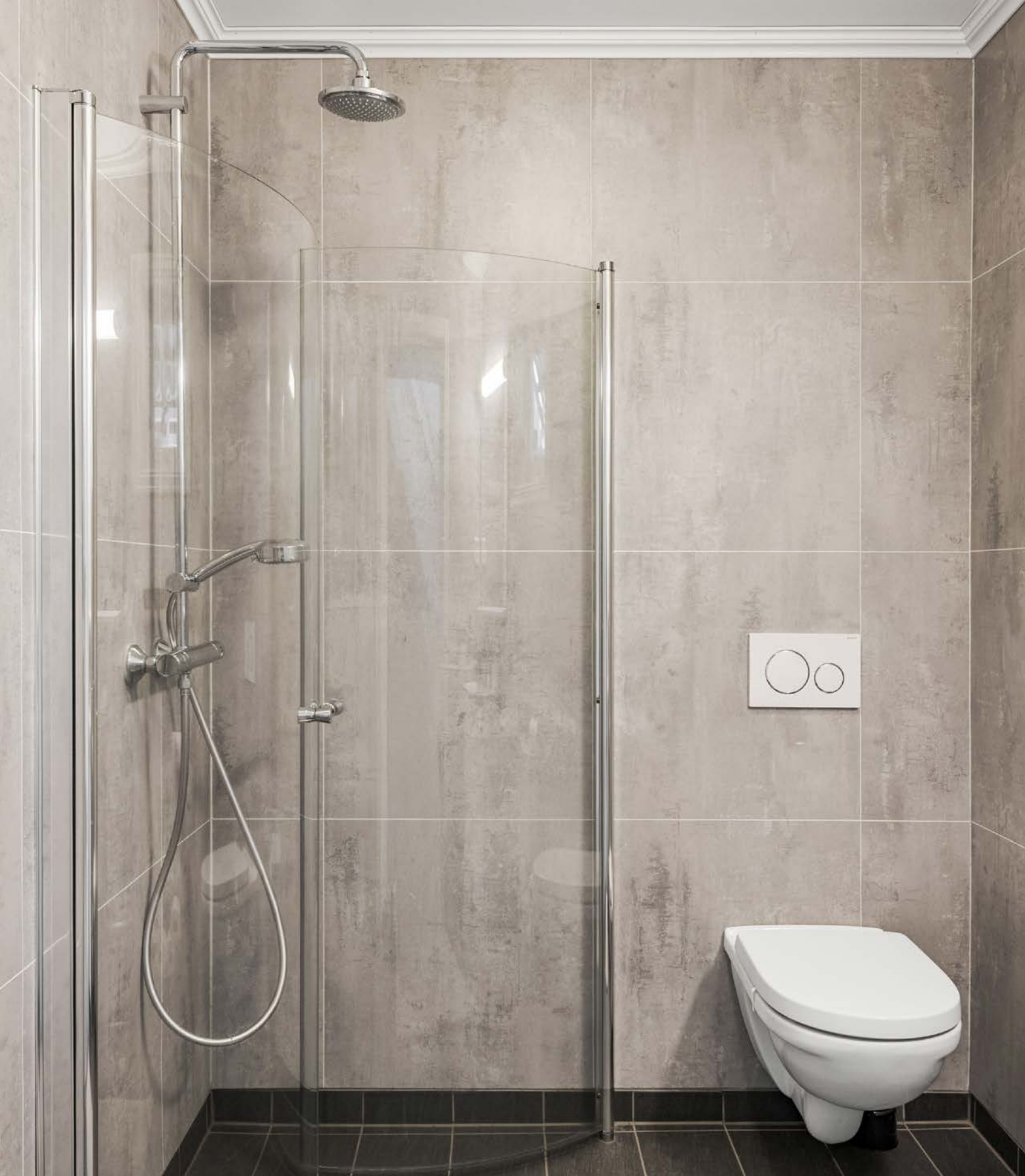
Moderne baderom i 1. etasje fra byggeåret 2018. Baderommet har flislagt gulv med vannbåren gulvvarme, våtromsplater på veggene, downlights i himlingen og avtrekk via balansert ventilasjon.
