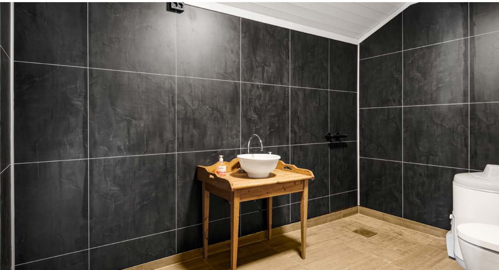
Baderom med overflater, installasjoner og komponenter fra 2023. Baderommet har flislagt gulv og overflater med våtromsplater og laftet tømmer.
