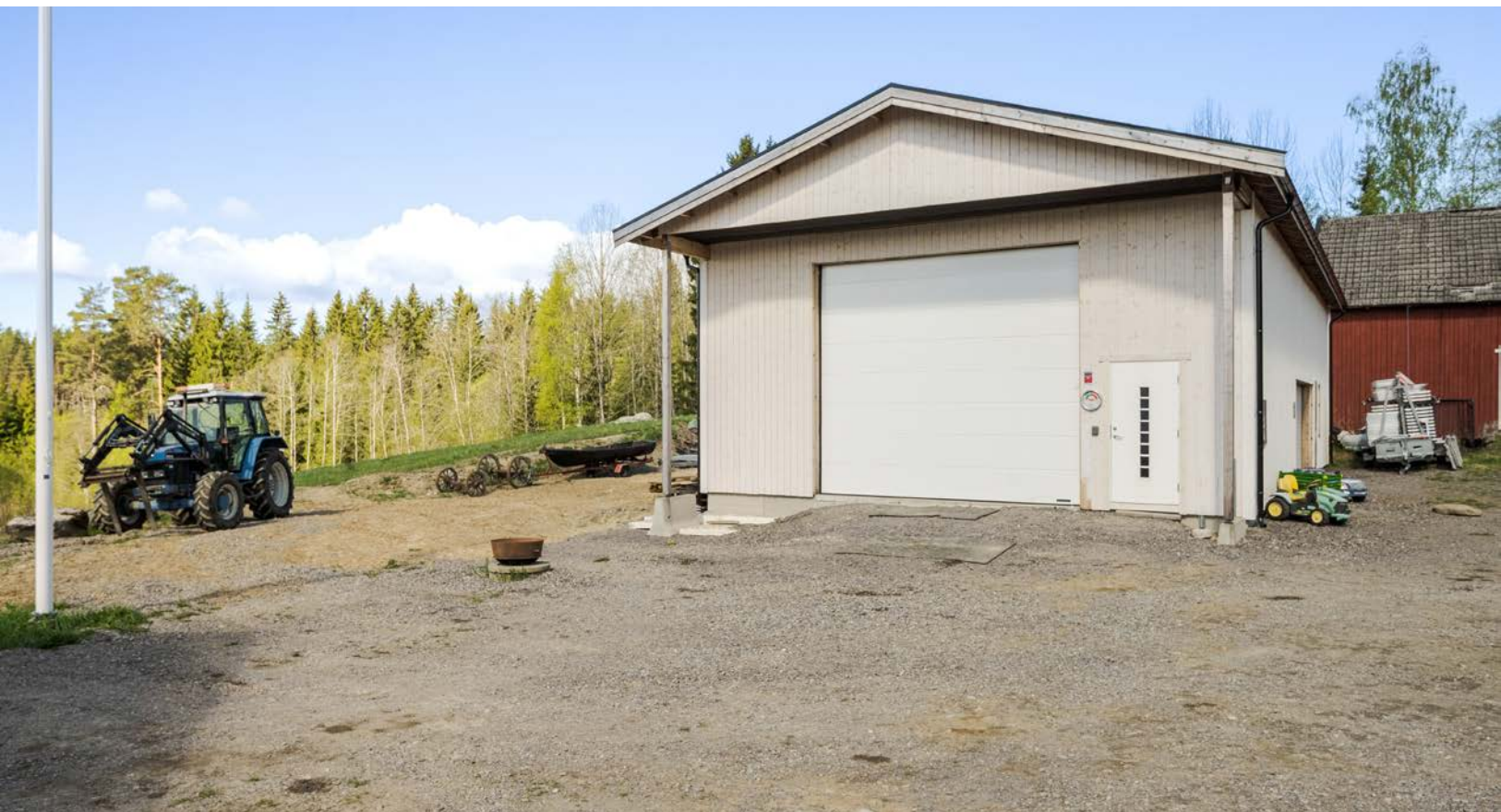
Stort garasjebygg fra 2026 med overbygget takkonstruksjon over inngang. Montert 2 stk. leddporter med motorstyring.
