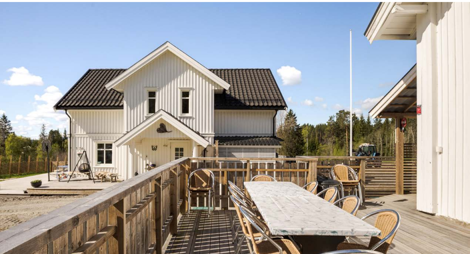
Terrassen som var ny i 2023 har impregnerte terrassebord på gulv og rekkverk av treverk. Beliggenheten på sydsiden av huset sørger for gode solforhold.
