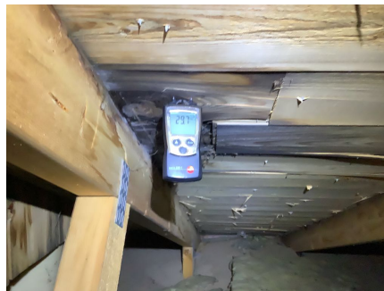
Taktro er våt inntil luftehatt.
