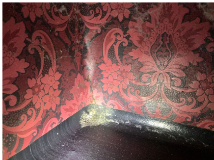
Revnet våtromstapet i hjørne.
