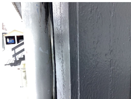
Frostsprengt nedløpsrør.
