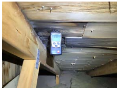
Taktro er våt inntil luftehatt.
