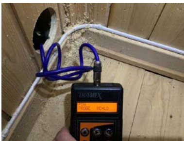
Hulltaking, og det måles tørt.
