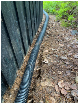
Rør over terreng for videreføring av takrennenedløp
