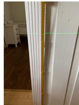
Laserlinje i sofa viser tydelig vesentlig høydeforskjell/fall i etasjeskille.
