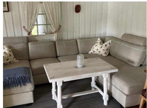
Laserlinje i sofa viser tydelig vesentlig høydeforskjell/fall i etasjeskille.
