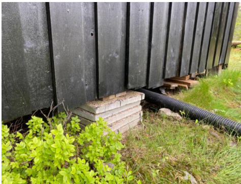
Eksempel på pilar av stablede betongheller.
