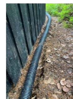
Rør over terreng for videreføring av takrennenedløp
