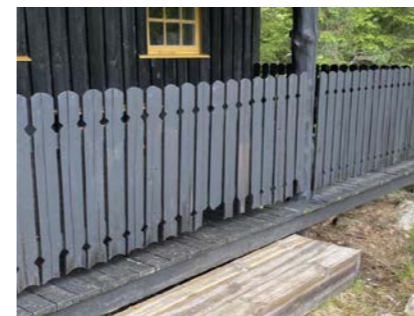
Rekkverk/hinder mot sau.
