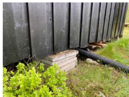
Eksempel på pilar av stablede betongheller.
