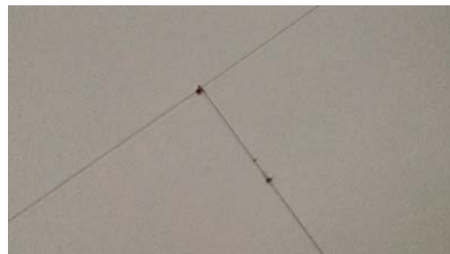
Eksempel på synlig innfesting av himlingsplater.
