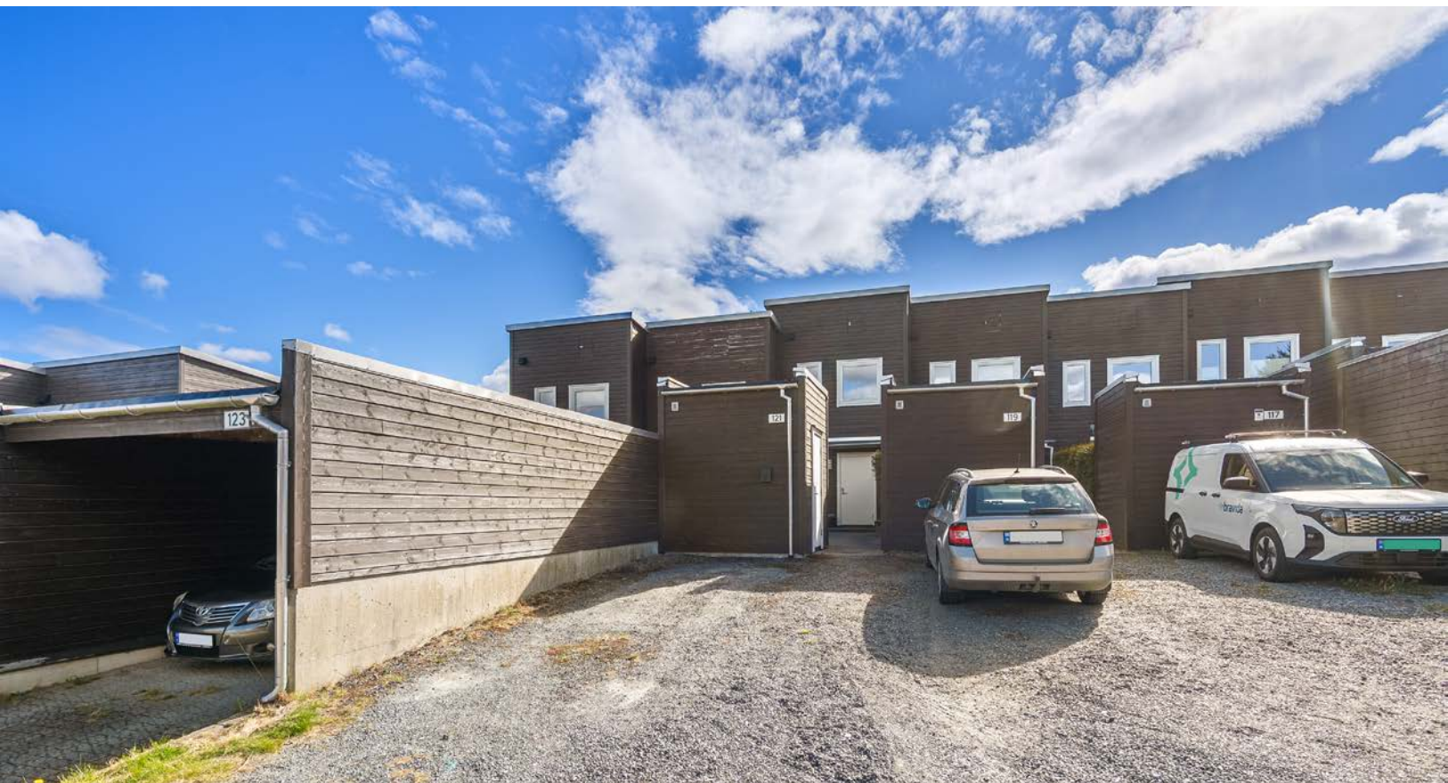
Biloppstillingsplass m/Zaptec ladestasjon montert i 2025. Utvendig bod med lagringsmuligheter.
