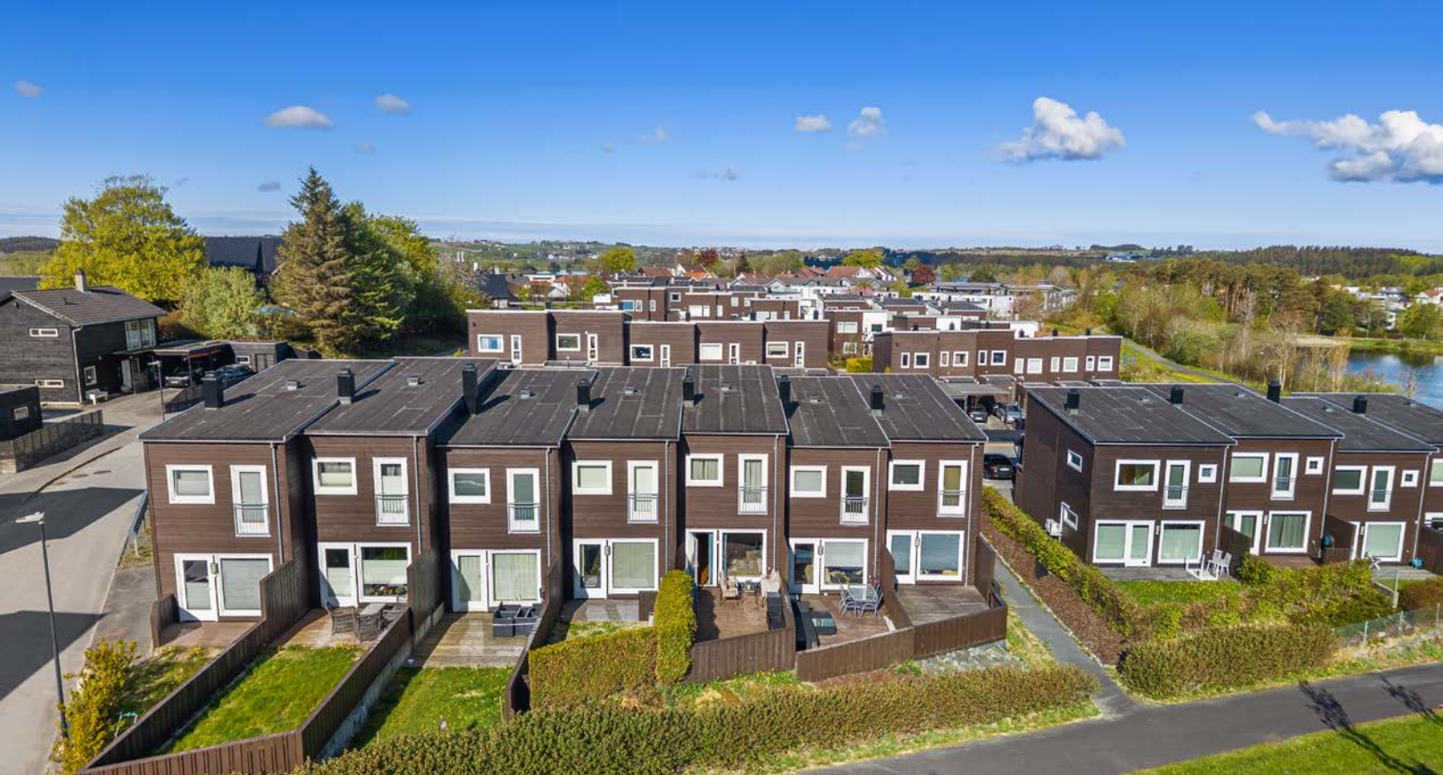
Rekkehuset ligger i et etablert og svært barnevennlig område på Kvernaland.
