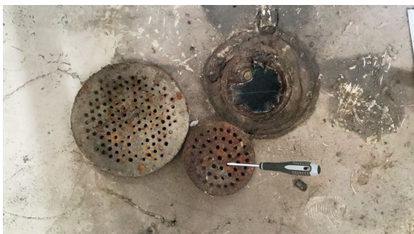
Sluk på bod i kjeller.
