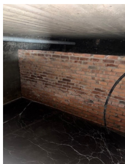
Ved enkle fuktsøk med fuktindikator registrerte jeg unormale verdier.
