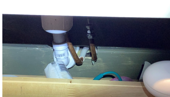
Utett gjennomføring i våtsone.
