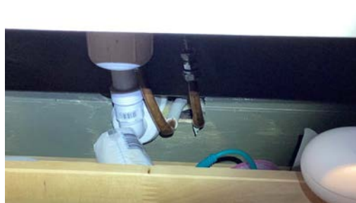
Utett gjennomføring i våtsone.
