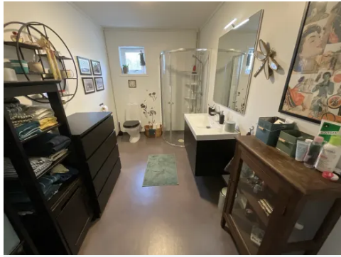
Våtrom med våtromsplater og belegg på gulv. Innredning med servant, klosset, dusjdører og opplegg for vaskemaskin.
