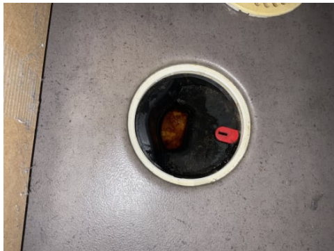
Hjelpesluk. Plastsluk med synlig klemring, tetsjikt er et belegg.
