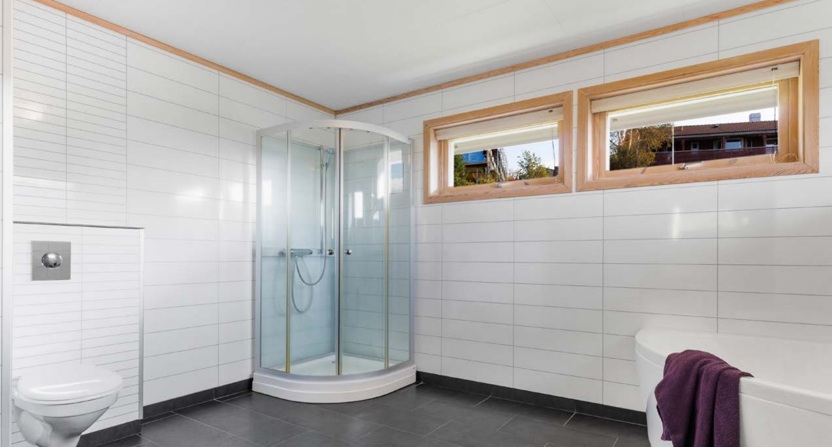
Hovedbad i første etasje - Fliser og varmekabler på gulv og våtromsplater på vegg
