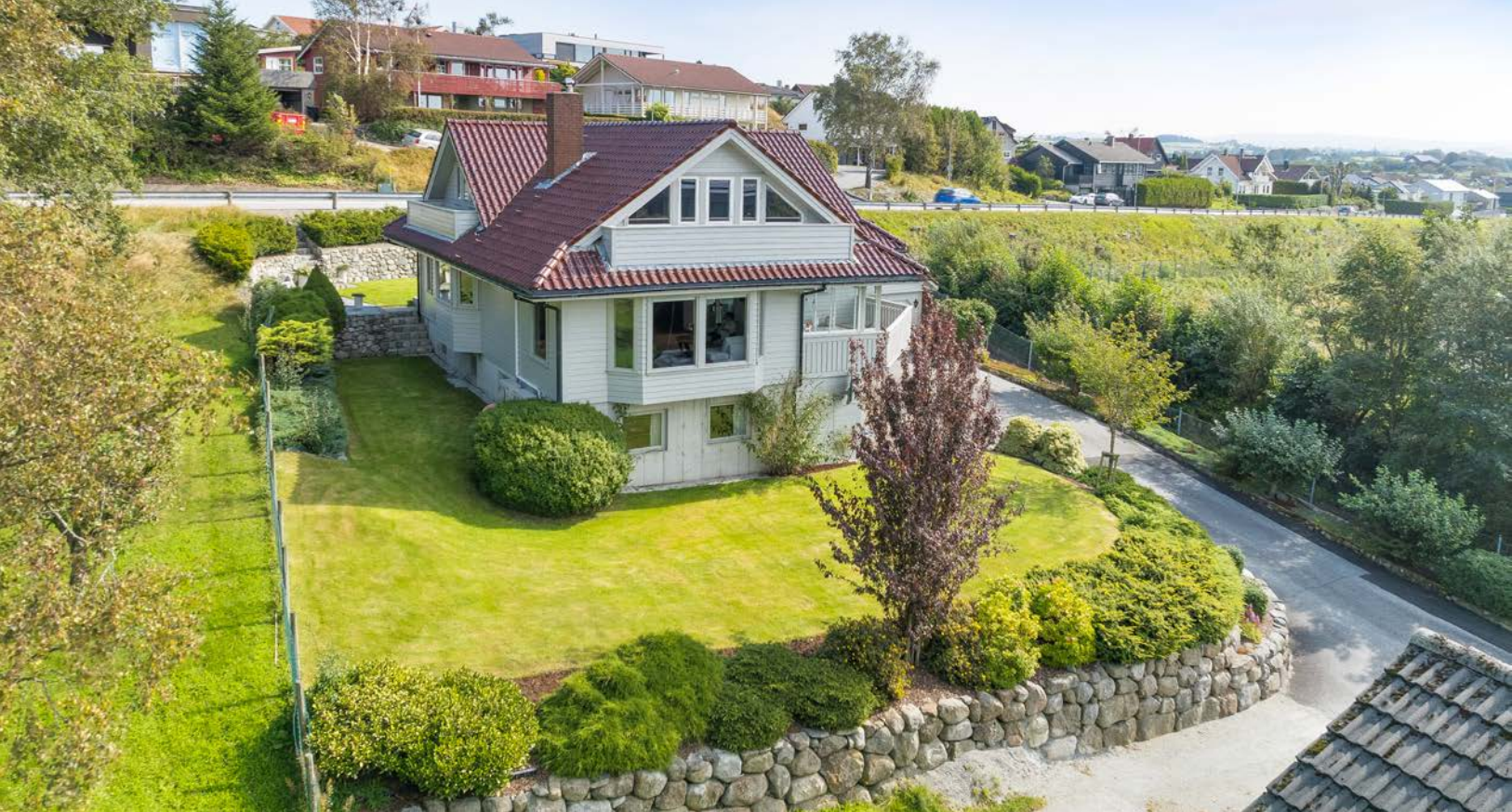
Pent opparbeidet uteområde med plen, beplantning og terrasse
