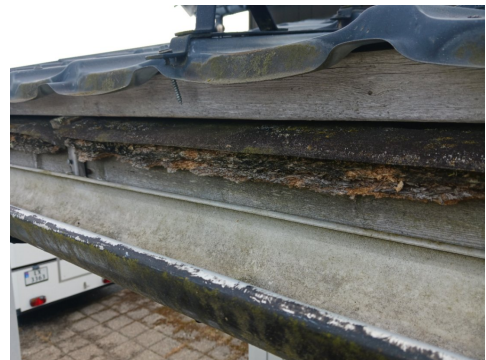
Undertak med sponplater
