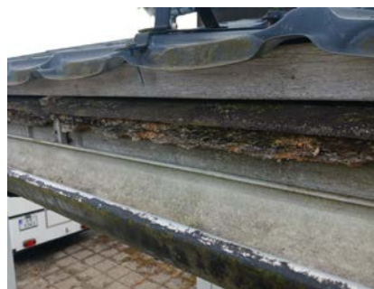
Undertak med sponplater
