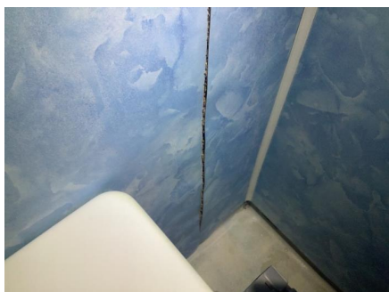
Fuktskadet baderomsplate.
