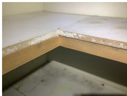
Sopputvikling på hylleplater i spiskammers.
