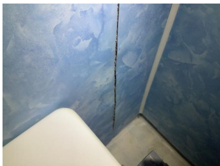
Fuktskadet baderomsplate.
