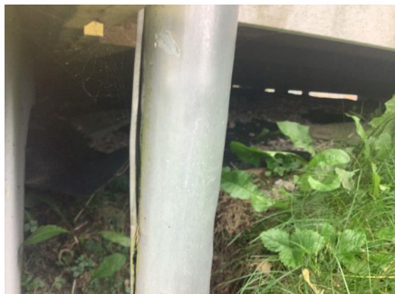
Frostsprengt nedløpsrør.
