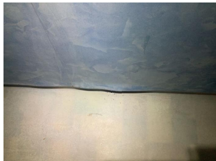
Fuktskadet baderomsplate.
