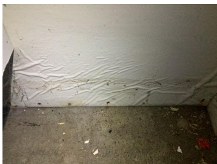
Fuktskadet veggplate.
