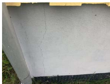
Eksempel på utvendig skråriss.
