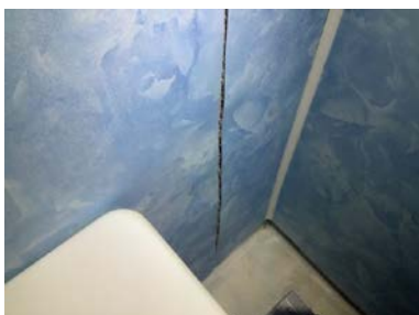
Fuktskadet baderomsplate.
