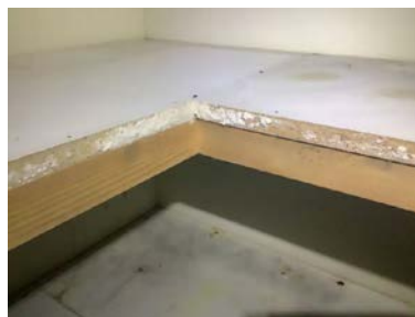
Sopp utvikling på hylleplater i spiskammers.
