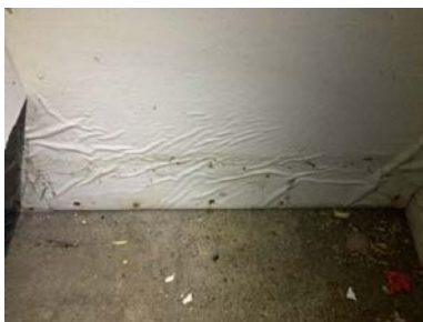
Fuktskadet veggplate.
