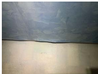
Fuktskadet baderomsplate.
