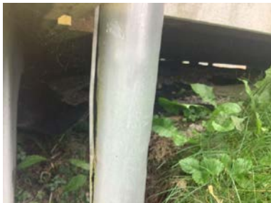
Frostsprengt nedløpsrør.
