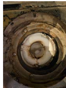
Kontroll av sluk under badekar.
