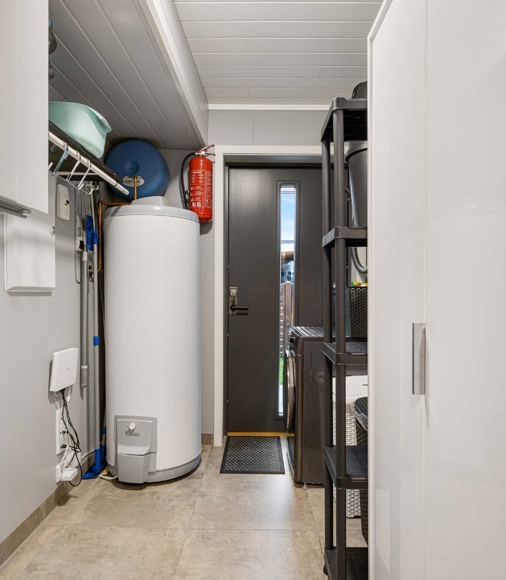
Også bi-inngangen ved entreen er utstyrt med opplegg for vaskemaskin.
