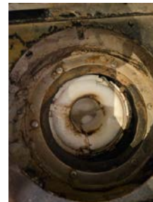
Kontroll av sluk under badekar.
